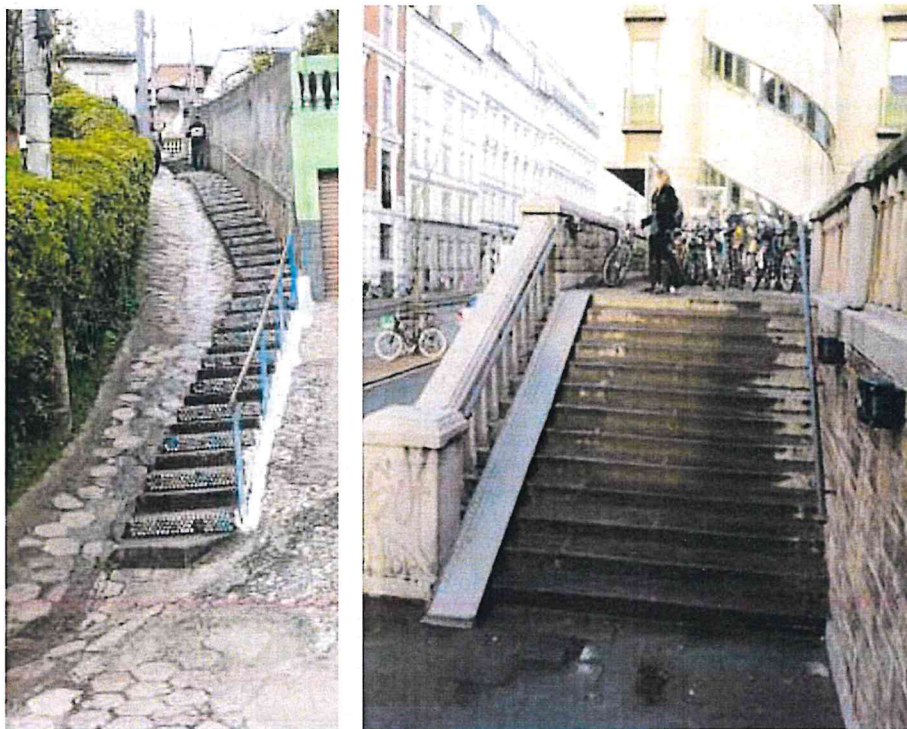
Figura 5.7 (esquerda): Escadaria com adequação de rampa e corrimão em São Luis do Paraitinga, SP. Foto: Suzana Nogueira
