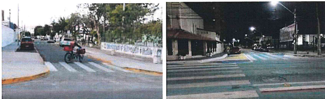
Figura 5.14. Exemplo de extensão da calçada com obras em Fortaleza. Fonte: Suzana Nogueira.
