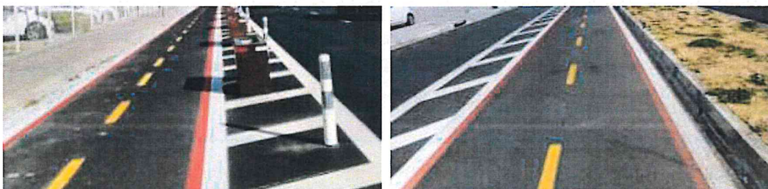
Figura 5.21. Ciclofaixa com buffer em diferentes trechos da Av. Santos Dumont. Fotos: Suzana Nogueira
