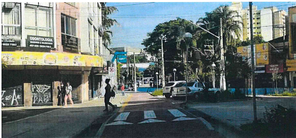
Figura 4.21: Exemplo de Travessia Elevada para Pedestres. Foto: Prefeitura Municipal de Diadema.
